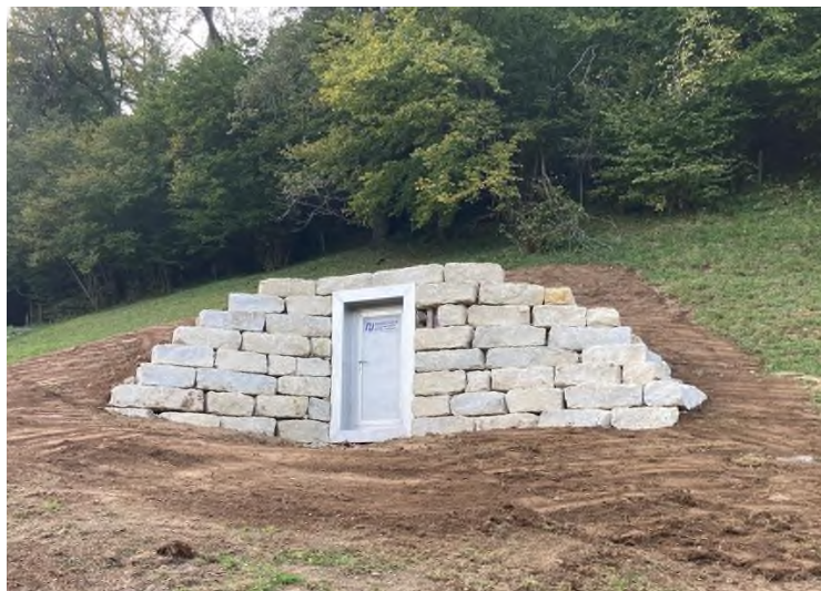
Bild: Aussenansicht Hochbehälter Schwaig
