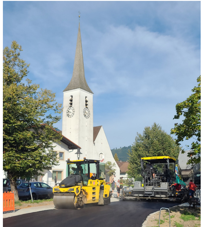
Foto: Aufbringen der Feinschicht vor der Sparkasse
